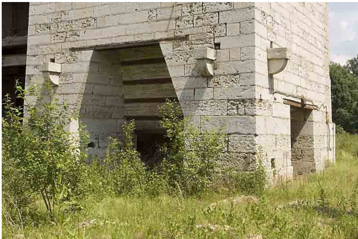
Base de la tour du haut fourneau.
