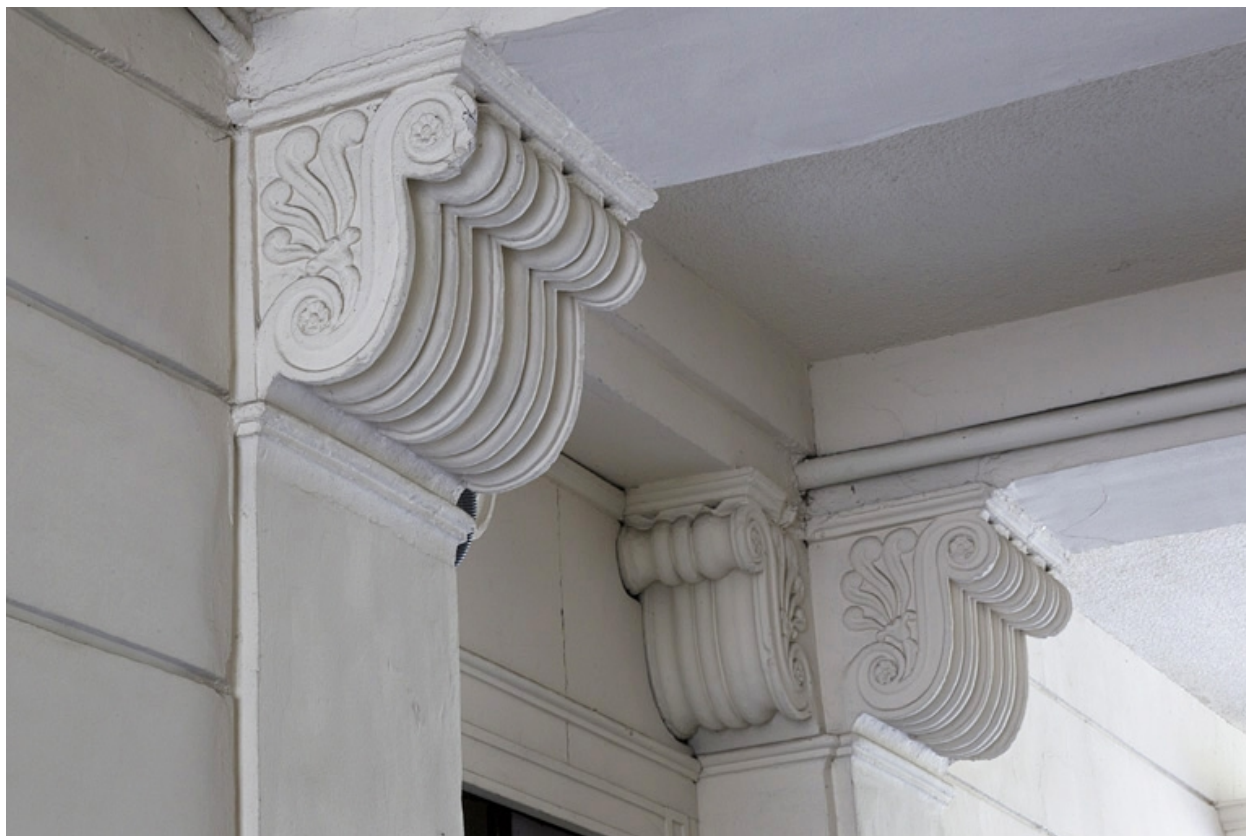
Passage cocher : détail d'une console.
