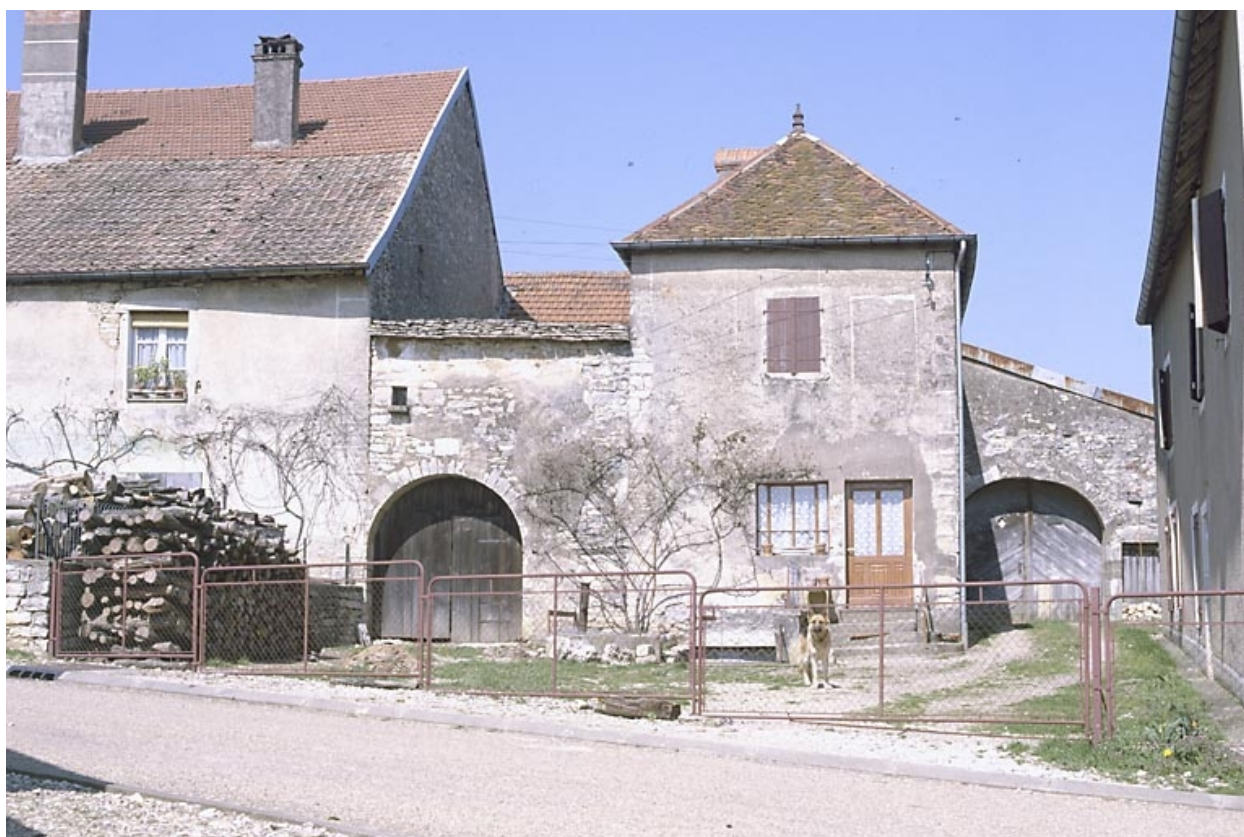
Façade antérieure sur cour en 1985.
