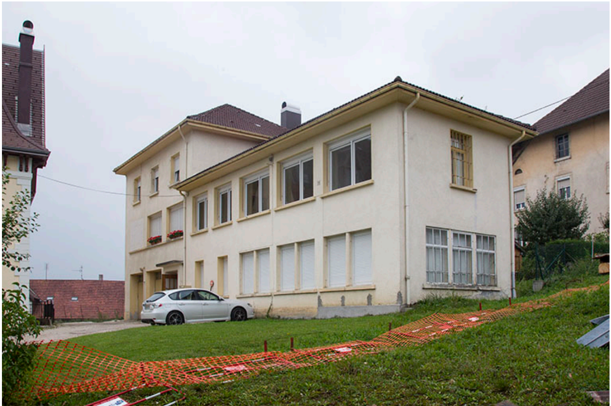
Usine, vue de trois quarts droite. A gauche, l'arrière du logement patronal.
