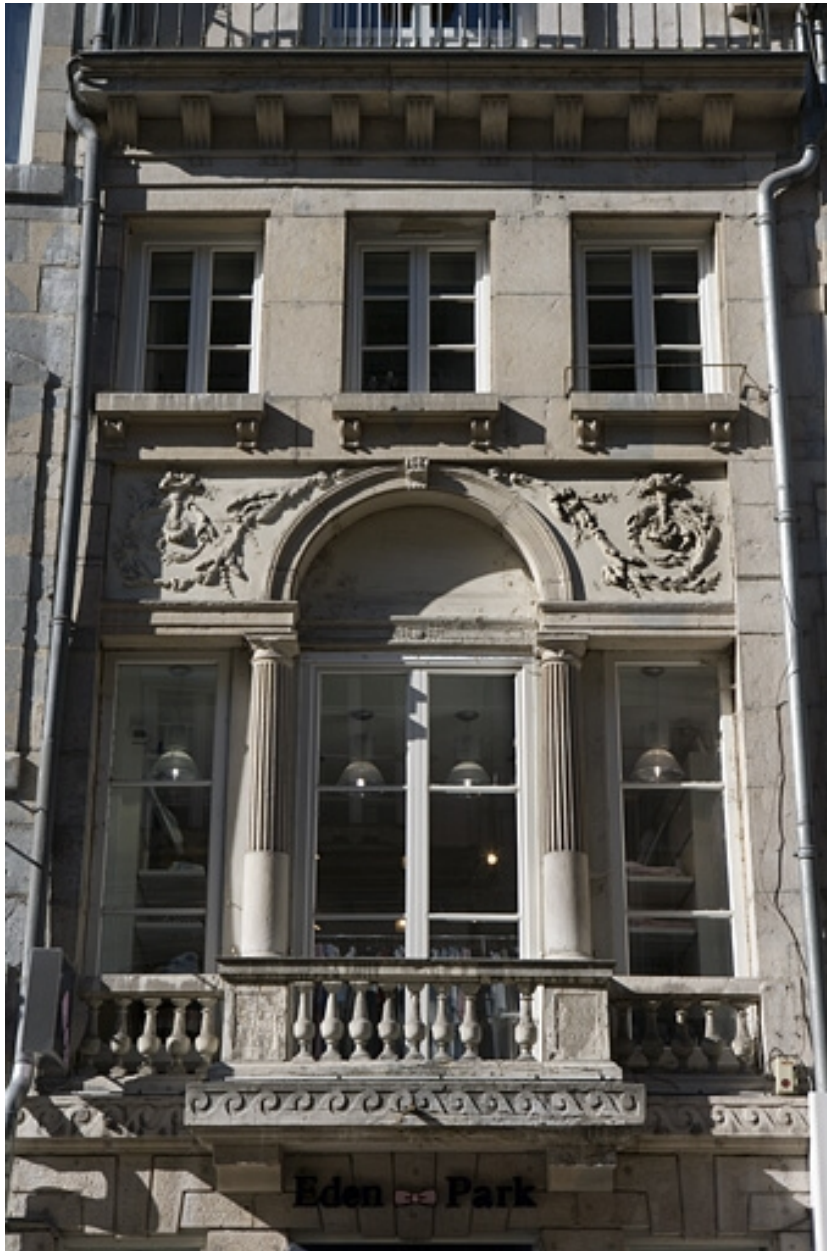
Détail de la serlienne du premier étage sur rue.
