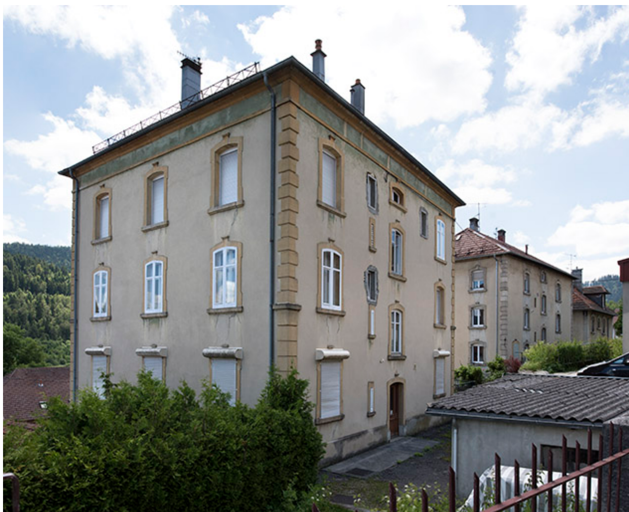
Façades postérieure et latérale droite.
