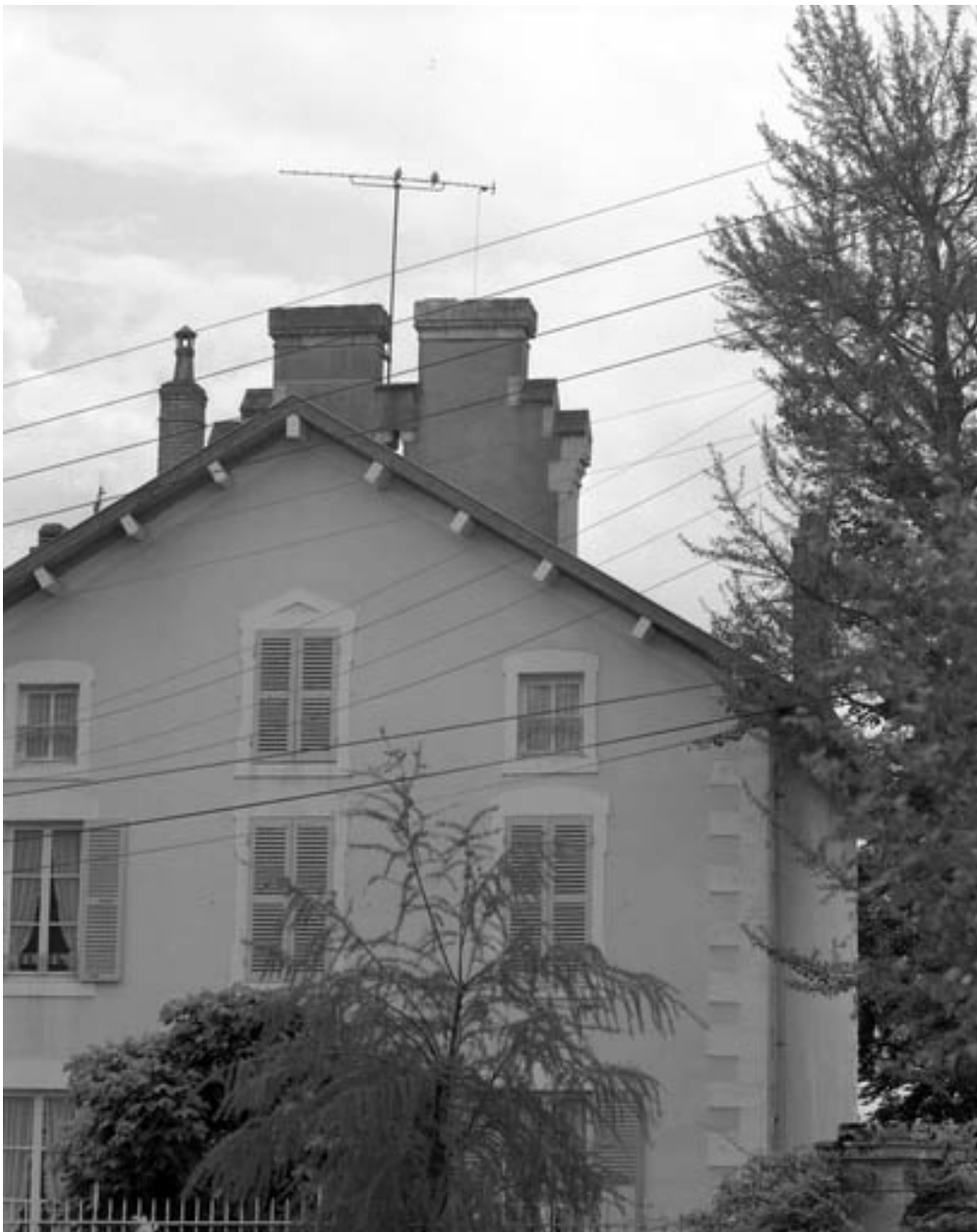
Détail de la façade antérieure sur pignon.
