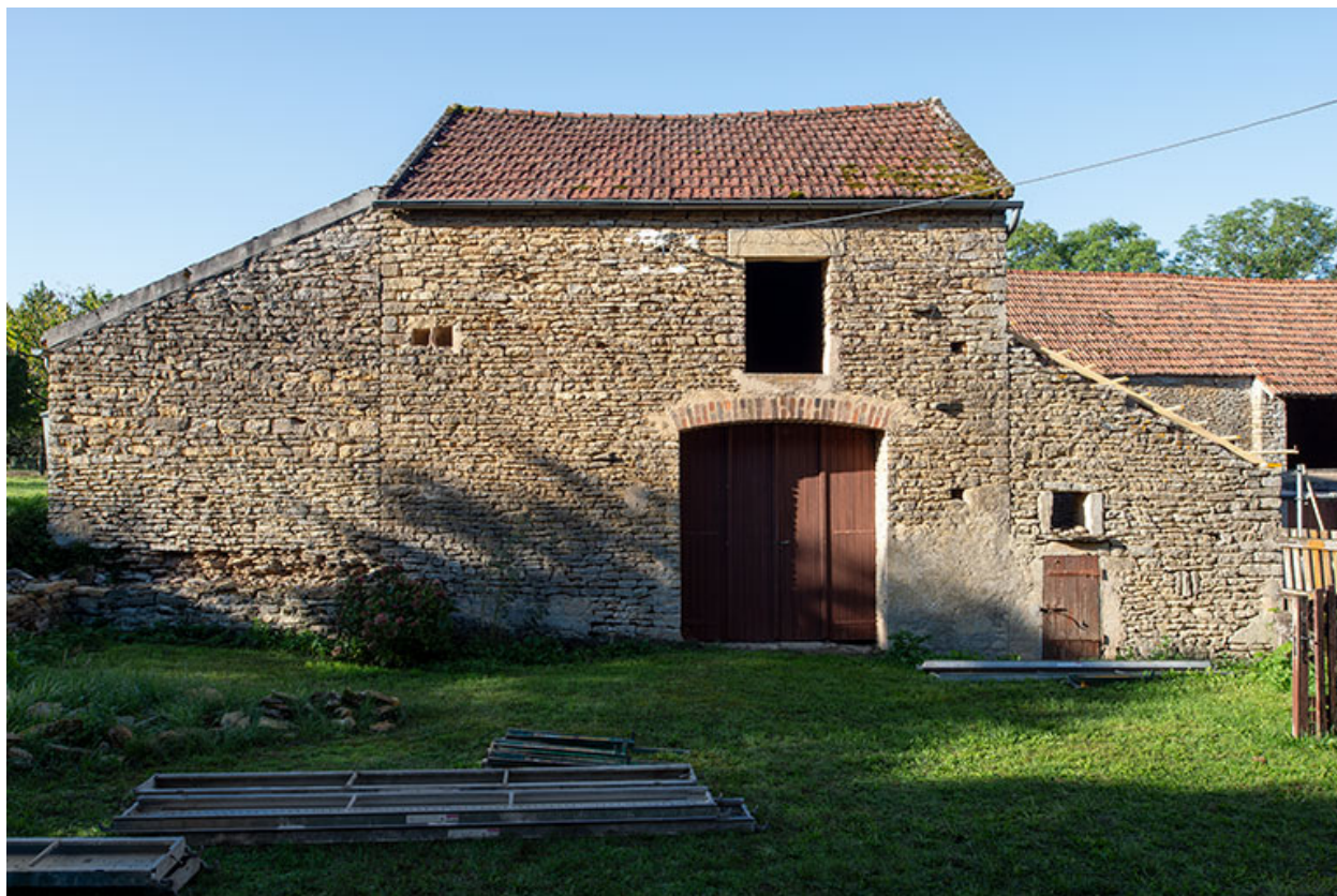
La grange secondaire depuis la cour.
