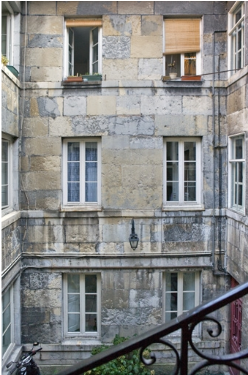
Détail de la façade en fond de cour depuis l'escalier à cage ouverte.
