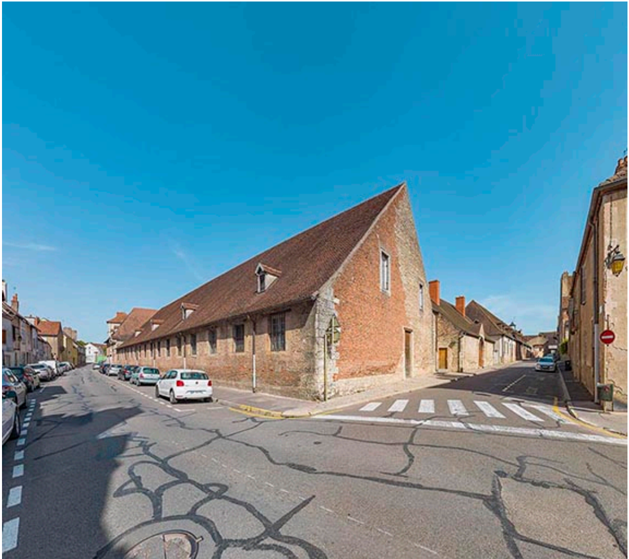
Les grandes halles depuis la rue Vauban.
