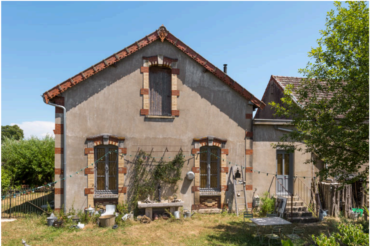
Salle de bal : façade latérale droite.
