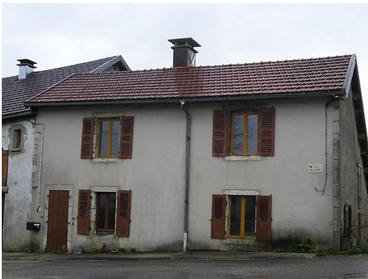
Vue générale sur façade antérieure.
