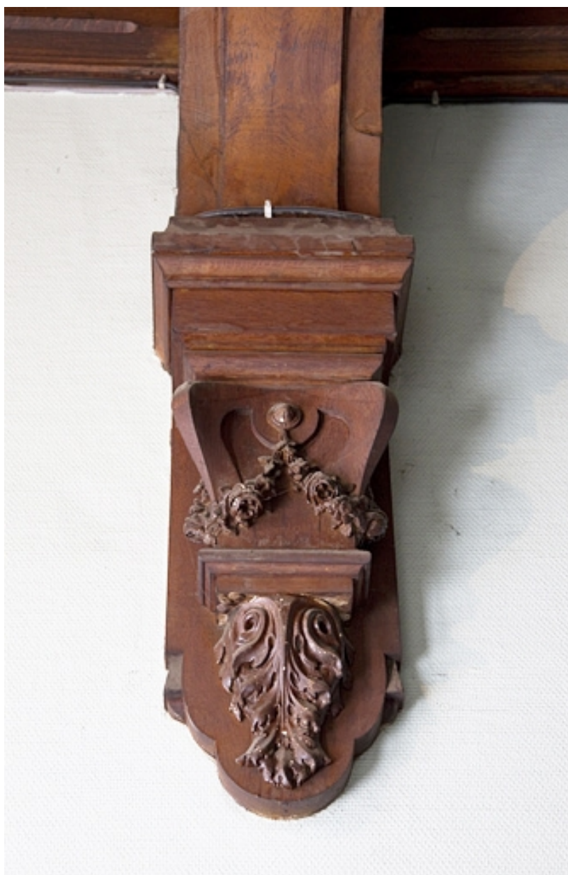
Intérieur, escalier : détail d'une console.
