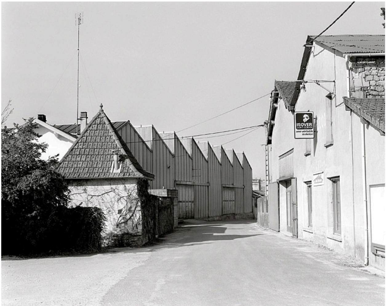
Façades sur la rue d'Allonal : atelier de fabrication (K).
