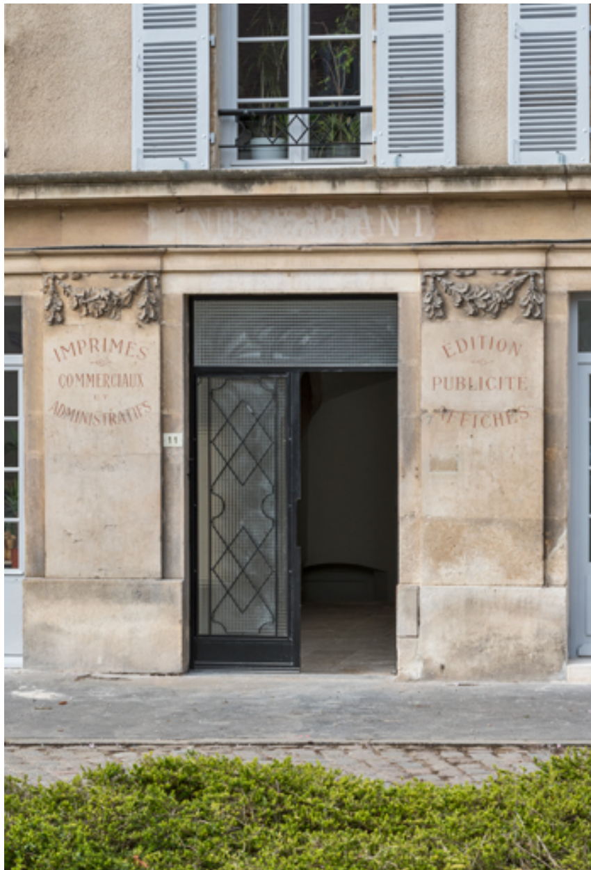
Façade antérieure : entrée.
