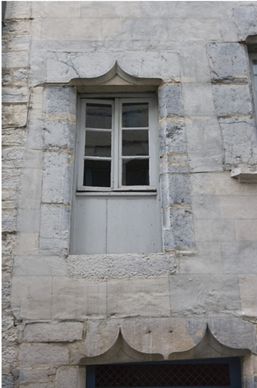
Rue Renan, détail d'une ancienne porte transformée en fenêtre au premier étage.
