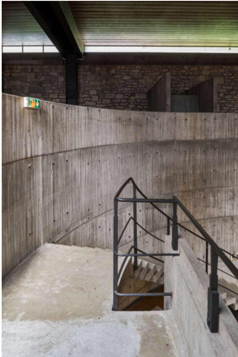
Mur rideau courbe séparant le dépositoire de la nef. Au premier plan, l'escalier courbe de la tribune sud.
