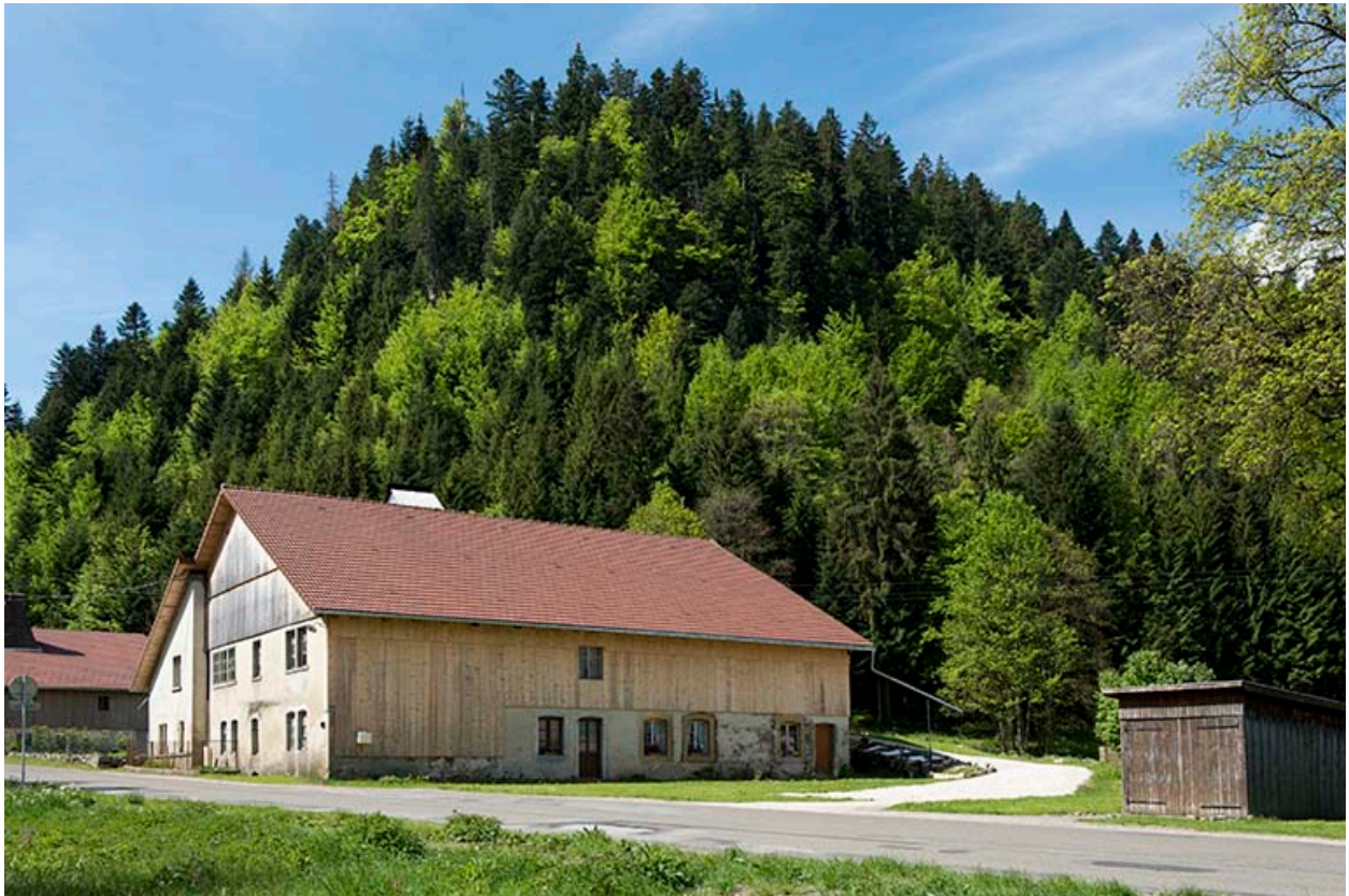
Façades nord et est.
