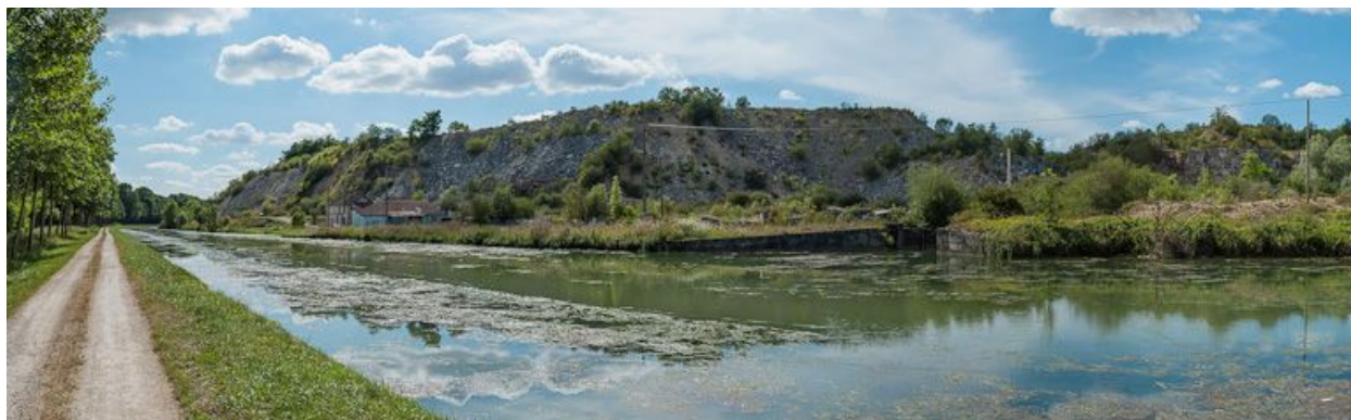
La carrière de Chassignelles et ses aménagements portuaires.
