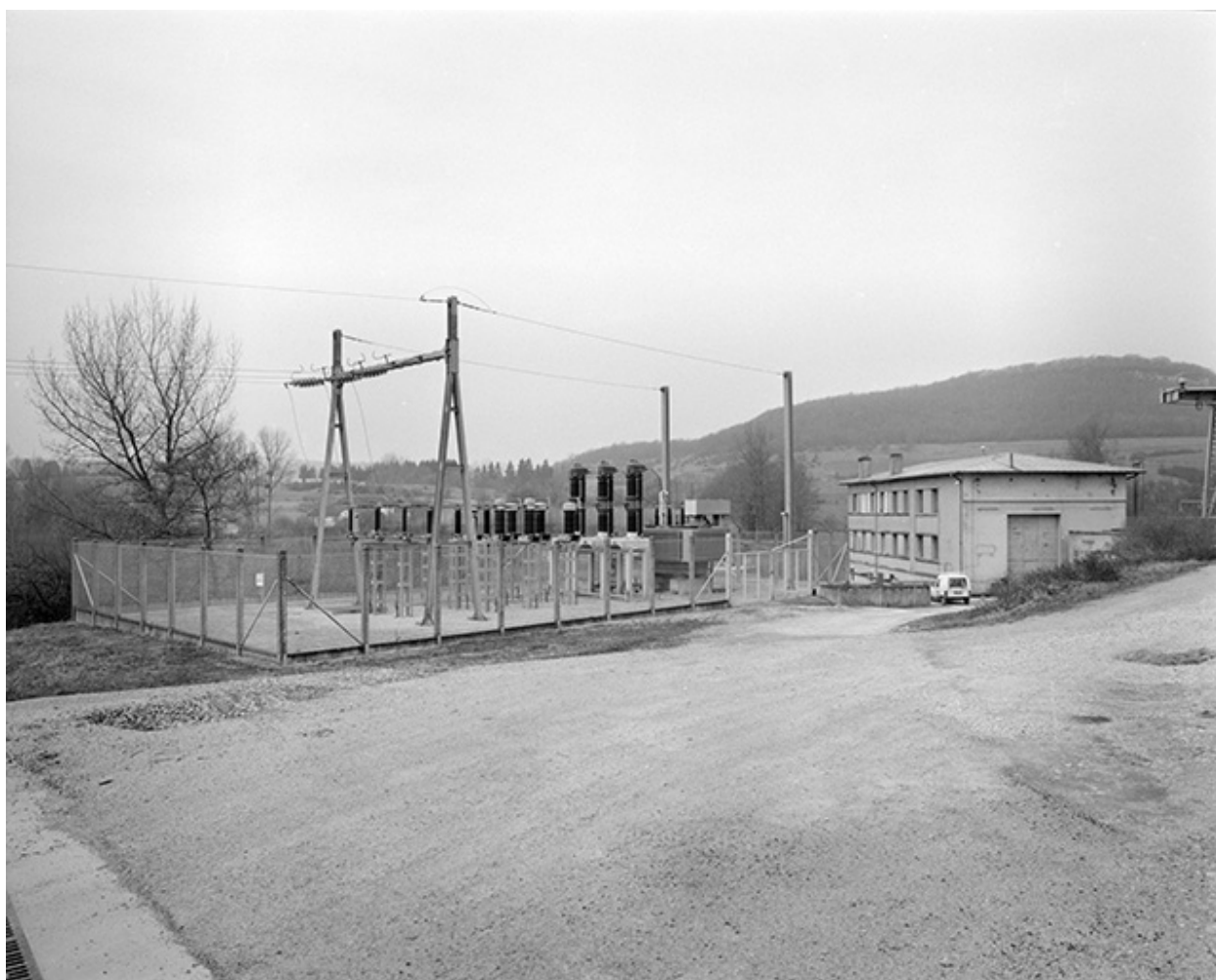
Transformateur et salle des machines.
