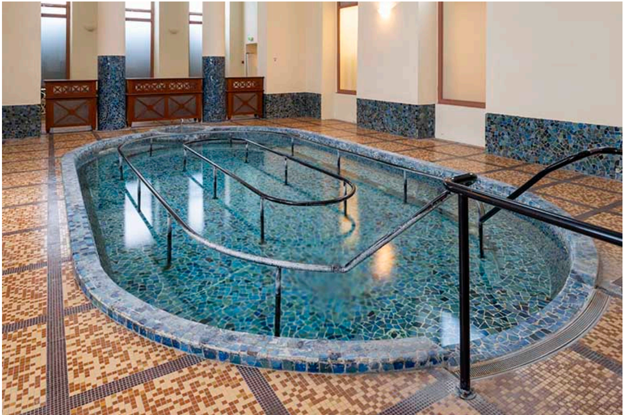
Piscine à l'emplacement du Grand Bain, bassin, vue en direction du nord-ouest.
