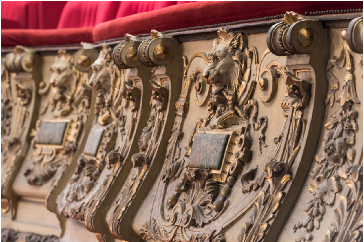
Garde-corps du 1er balcon, vue en enfilade.
