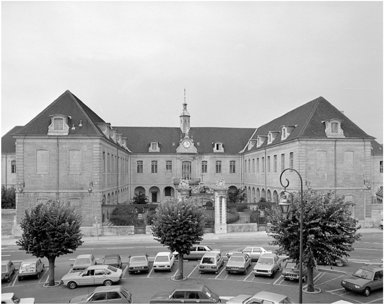
Vue de la partie centrale de l'édifice avec sa cour ouverte.
