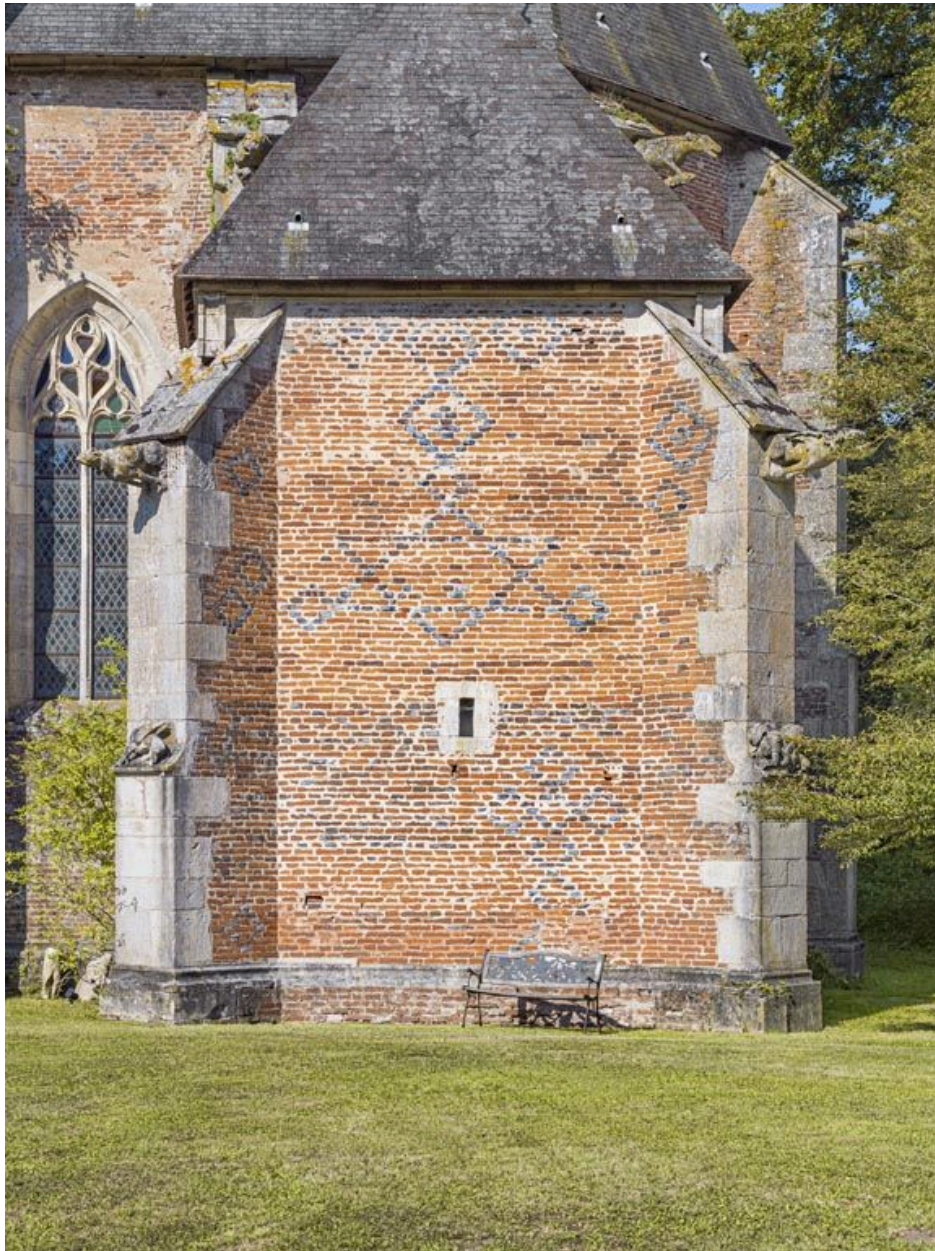
Mur extérieur de la chapelle droite.
