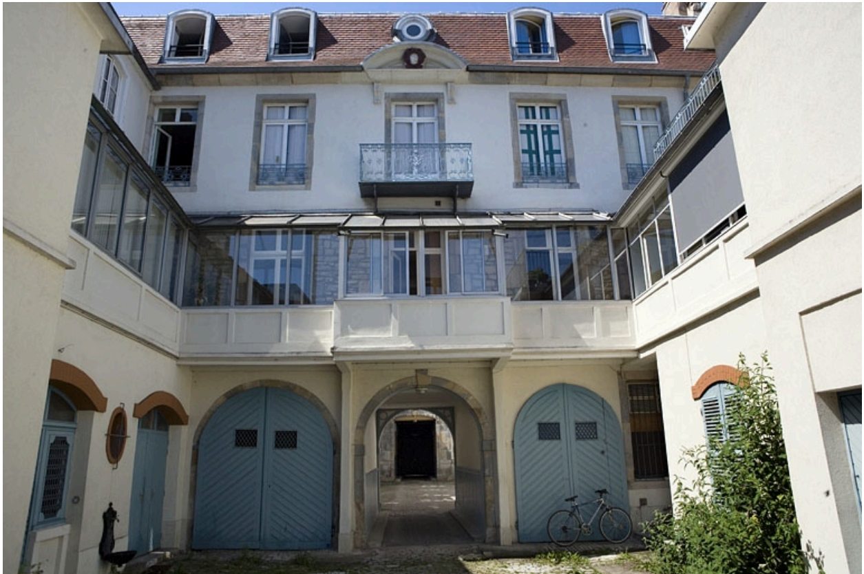
Façade postérieure du logis secondaire, de face.
