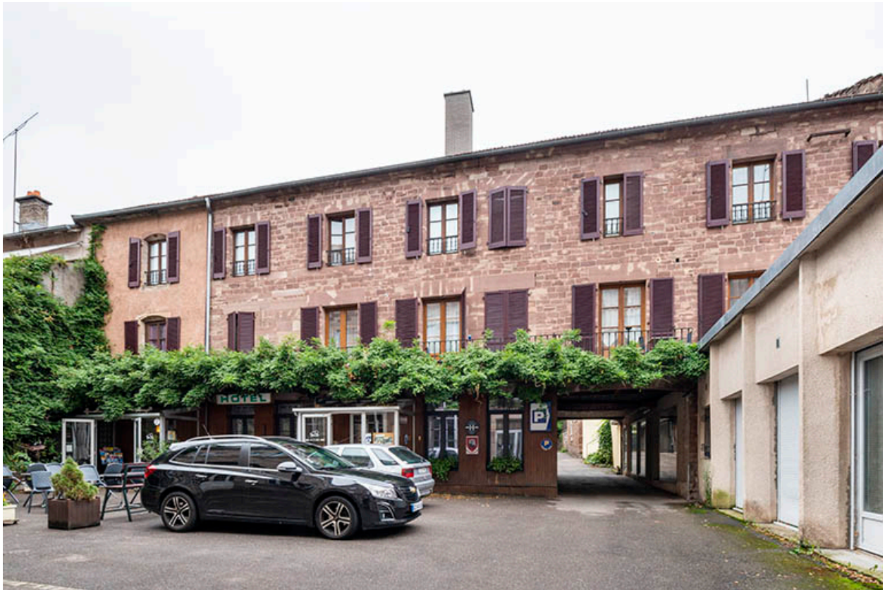
Façade sur la cour du corps côté cour.
