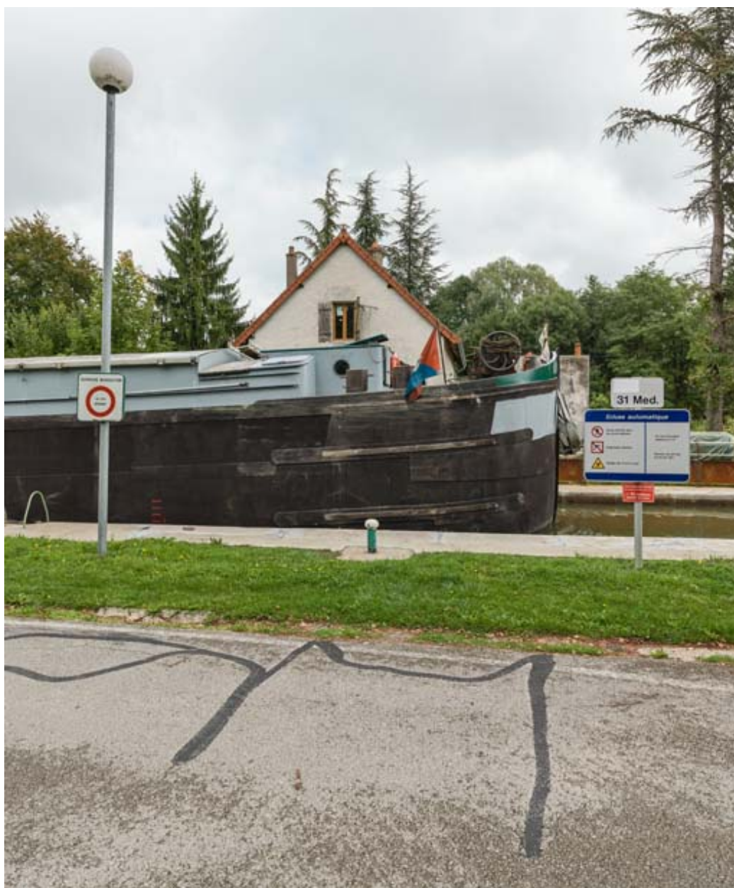
Vue rapprochée de l'écluse.
