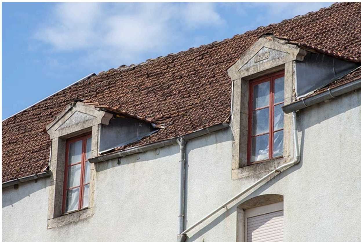
Les deux lucarnes du surcroit.
