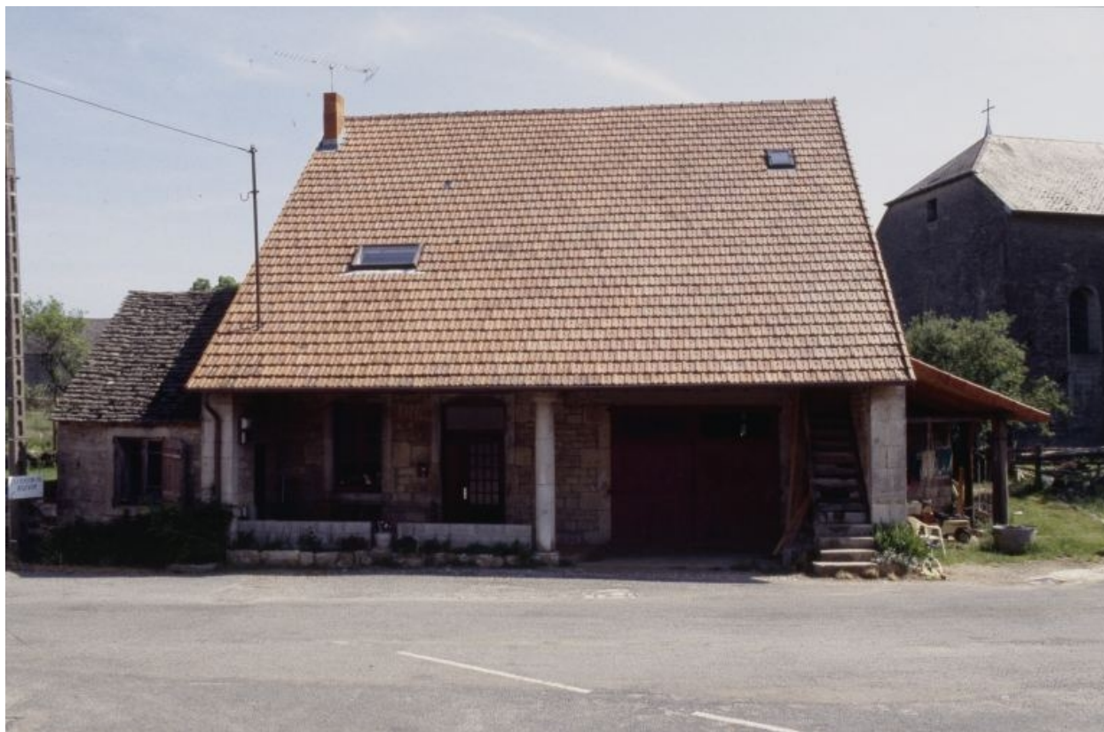
Façade antérieure vue de face.
