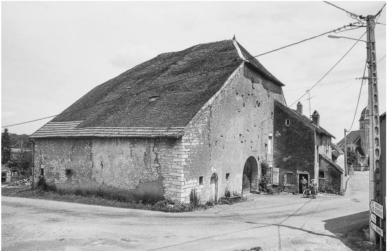
Façades antérieure et latérale gauche.
