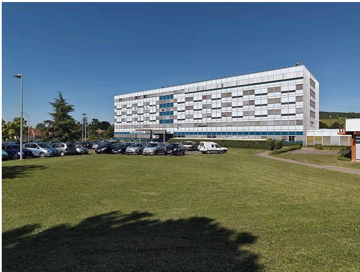
Bâtiment principal, vue d'ensemble.
