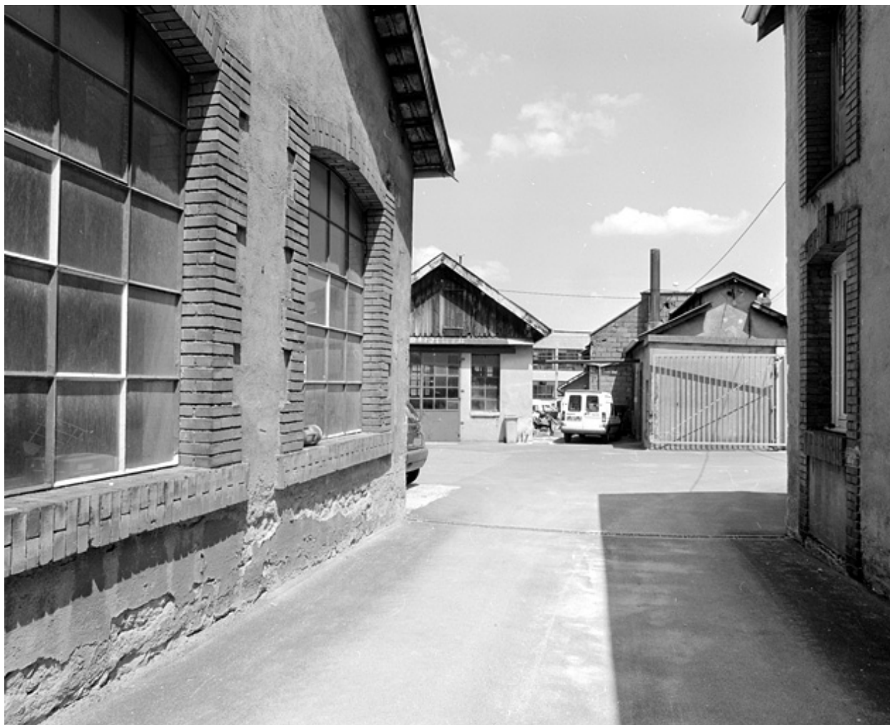
Magasins généraux : passage vers la cour.
