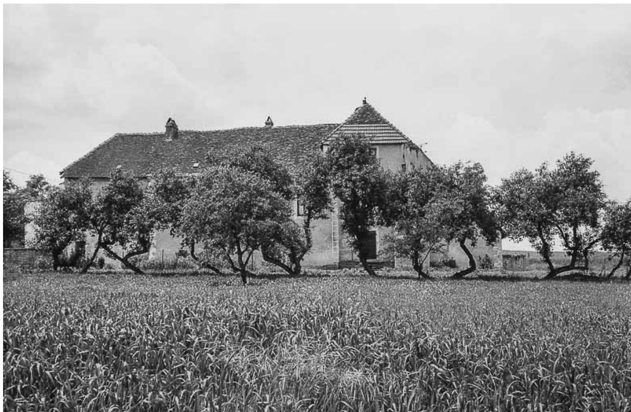
Façade postérieure du bâtiment.
