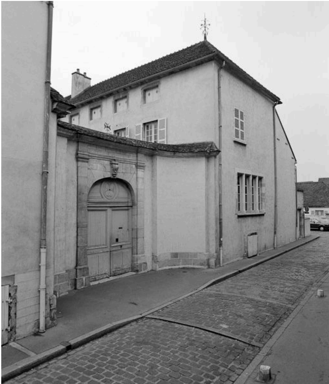
Portail principal et mur de croupe sud du bâtiment des services Sainte-Anne et Saint-Antoine.
