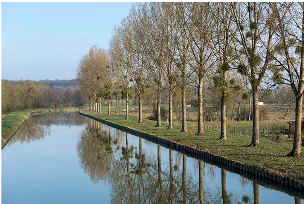
Le canal, vue vers l'amont.
