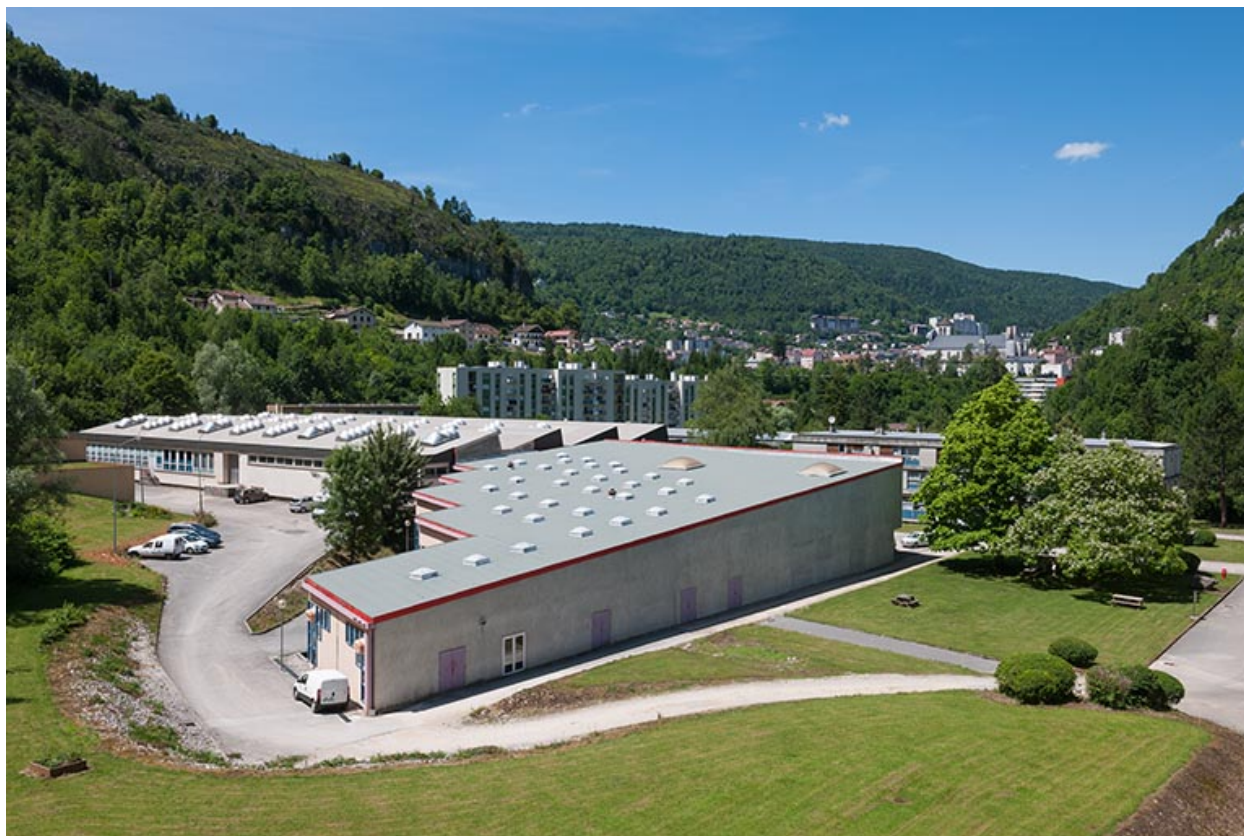
Ateliers : vue d'ensemble des toitures.
