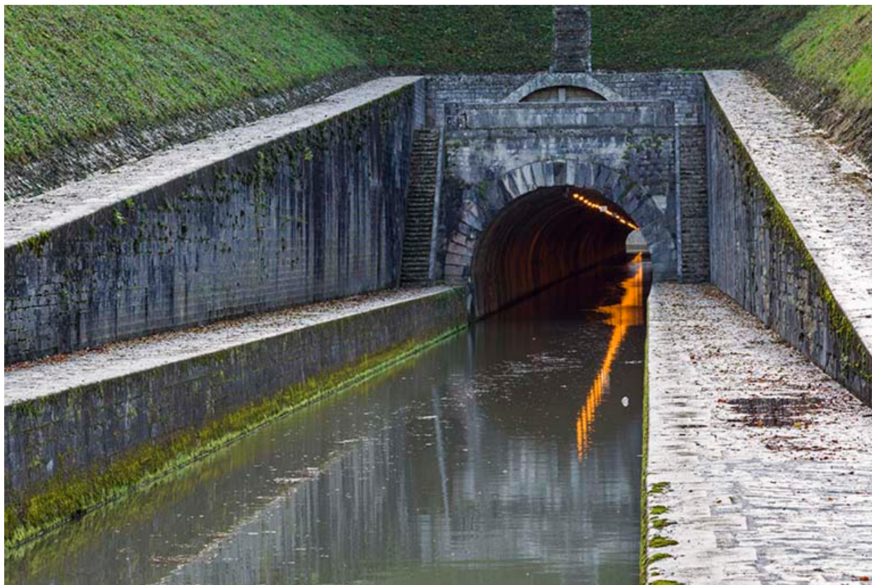
Le tunnel de Saint-Albin.
