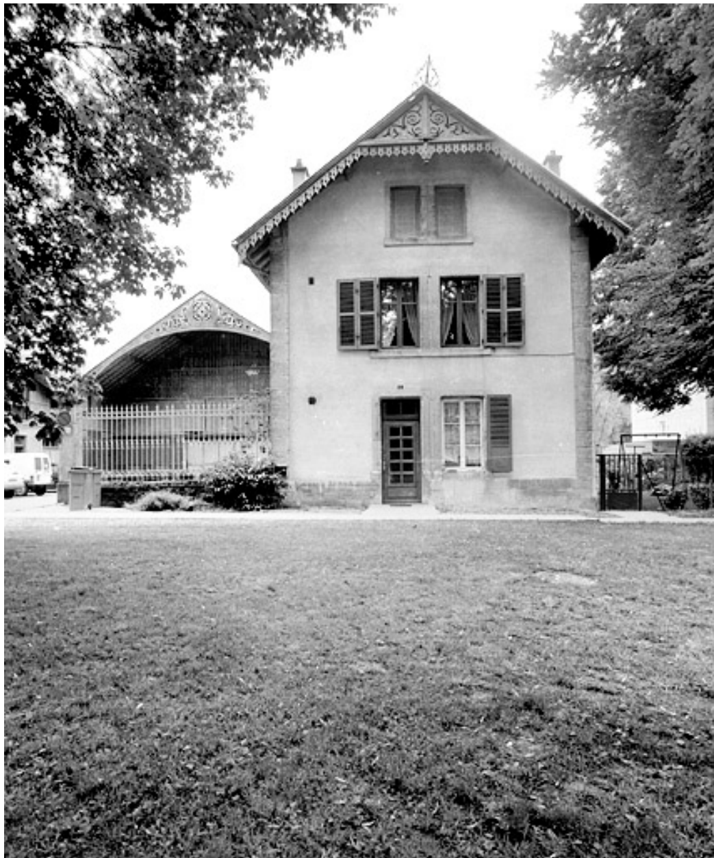
Les écuries : façade du logement.
