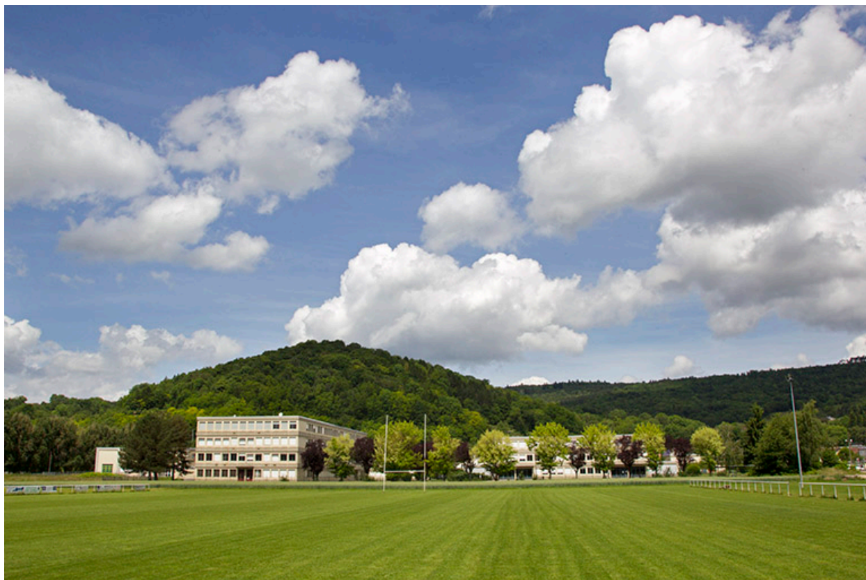
Baume-les-Dames, lycée professionnel Jouffroy d'Abbans : vue depuis le sud.
