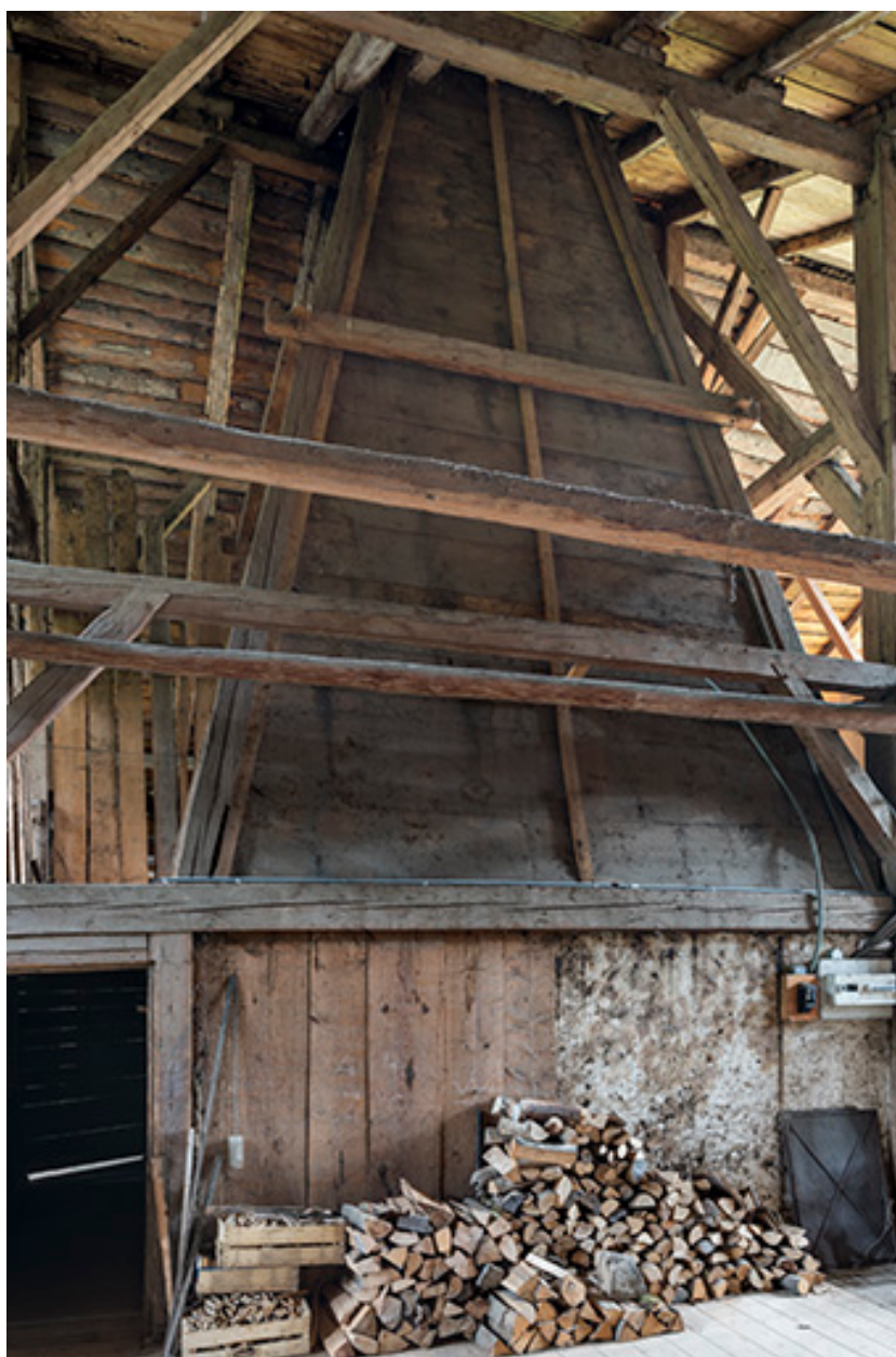
Intérieur, grange : hotte du "tué" central.
