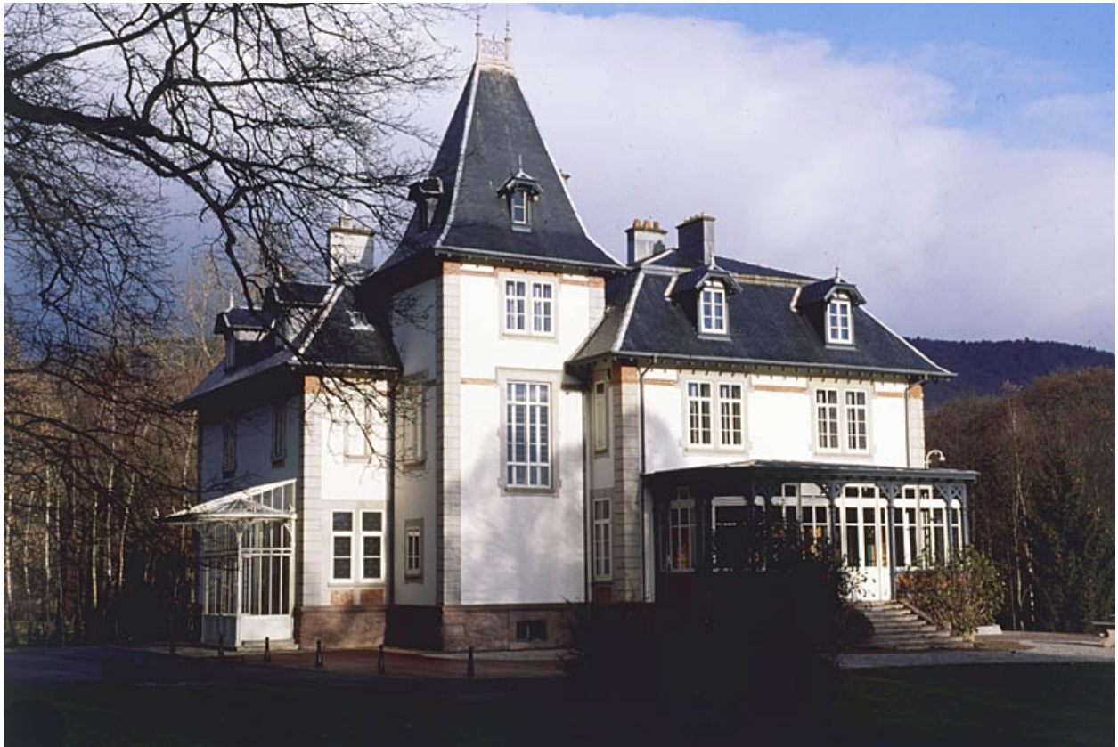
Façades sud du logement patronal.
