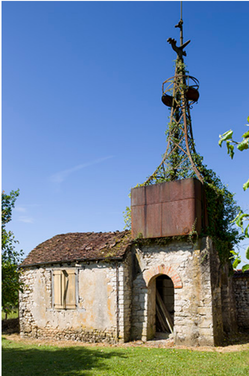
Vue rapprochée du bâtiment et de l'éolienne.
