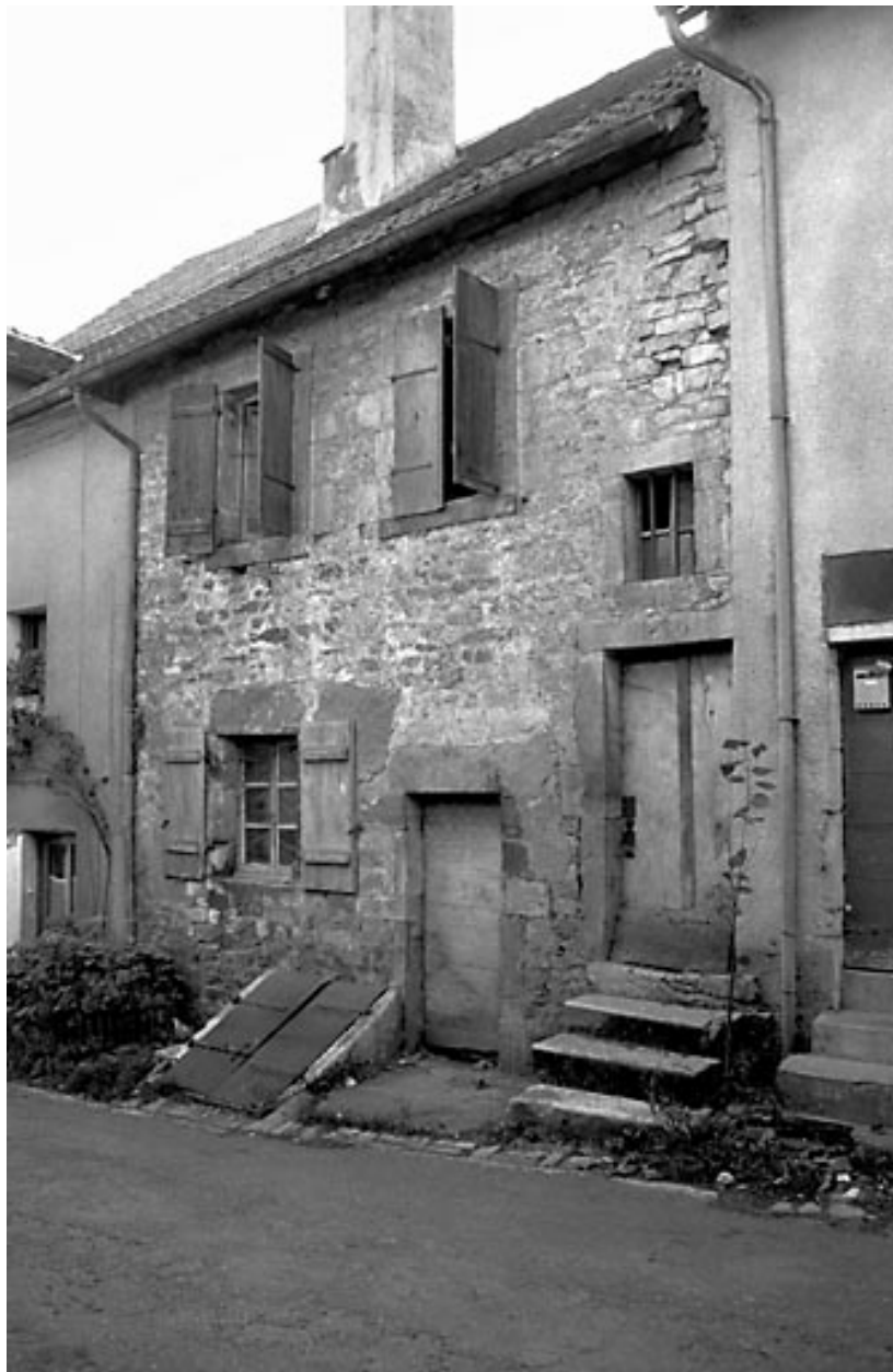
Maison située rue Gambetta.
