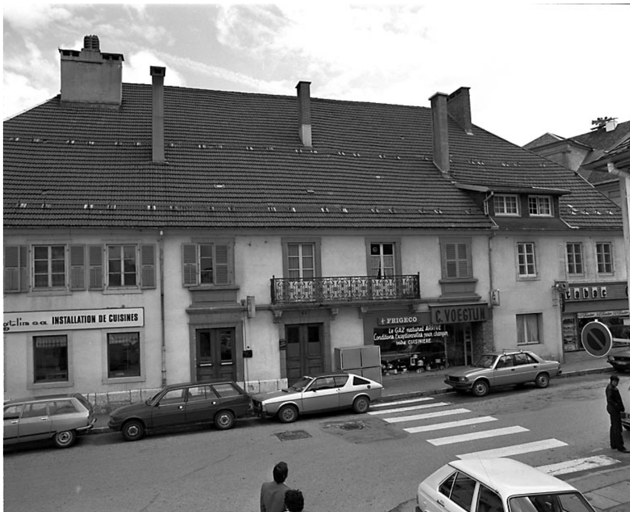
Maison située 9 rue de la Halle.
