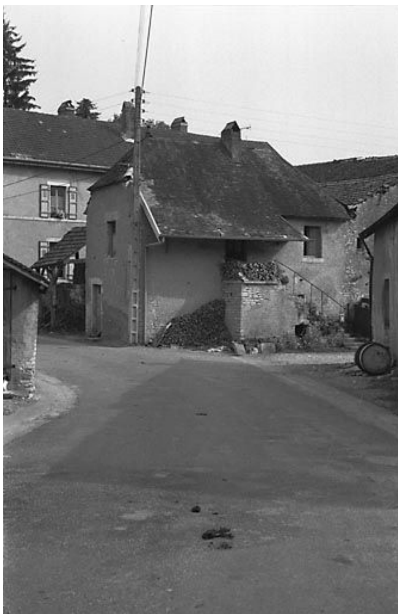
Maison située rue de la Fontaine.
