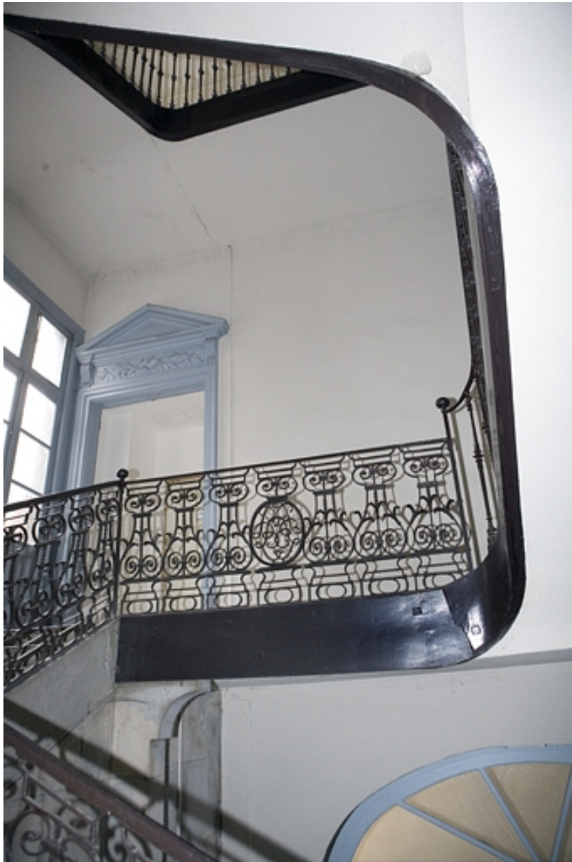
Détail de la rampe de l'escalier.
