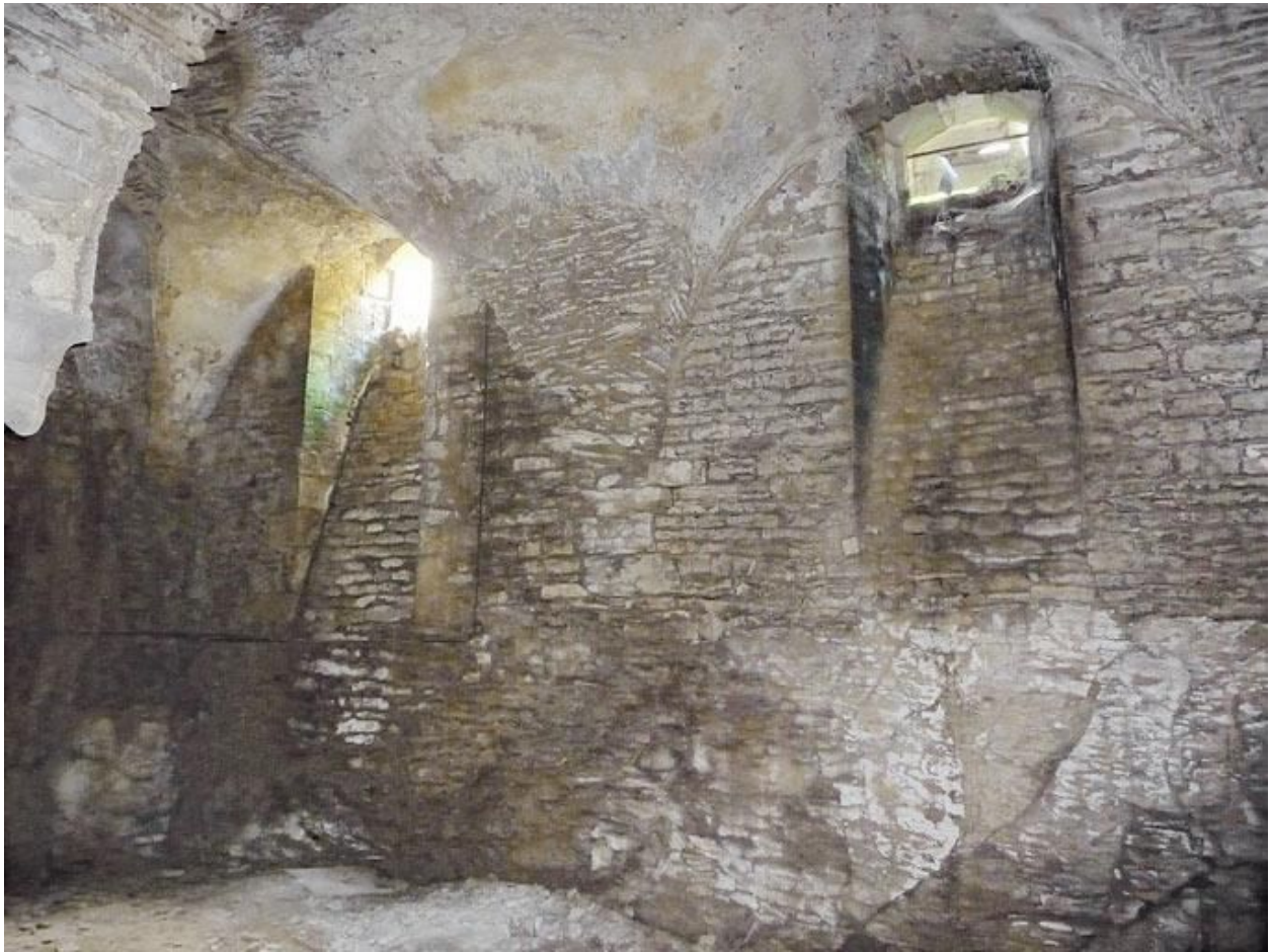
Cave sous la grange : voûte et soupiraux.
