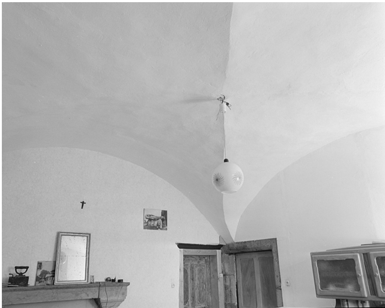
Pièce du rez-de-chaussée, voûte d'arêtes.
