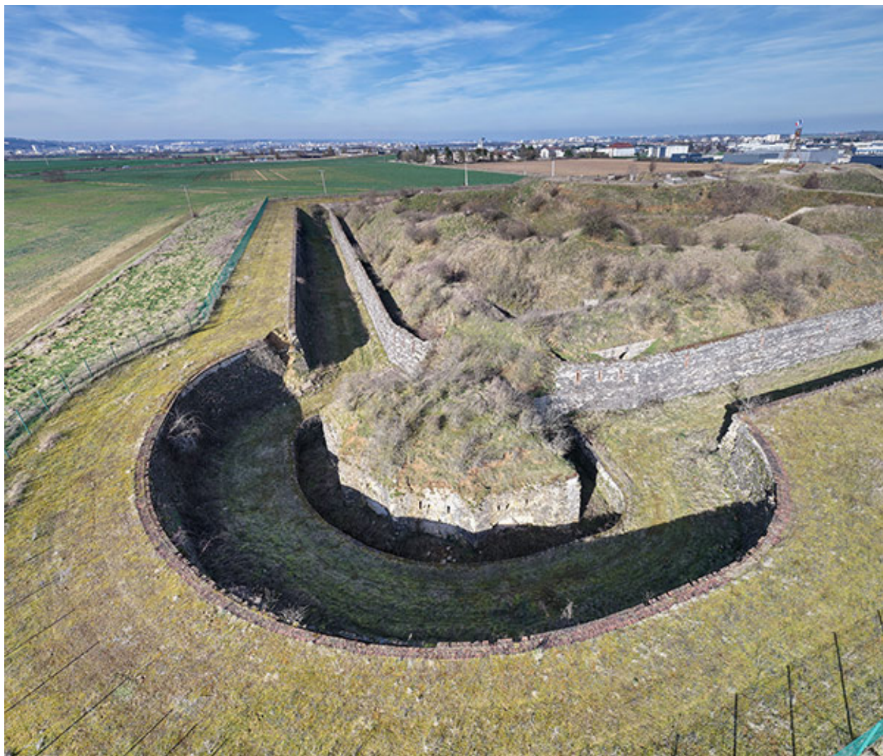
La double caponnière, au saillant 3. (vue aérienne).
