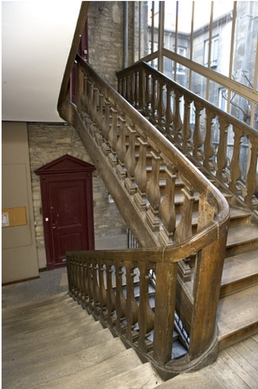
Détail du premier escalier à cage ouverte depuis l'intérieur de la cage.
